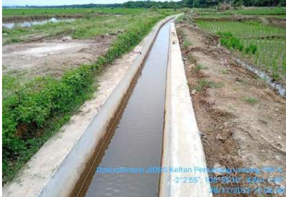
Pembangunan/Rehabilitasi Jaringan Irigasi Tersier di Nagari Tluk Kualo Kec. Air Pura
