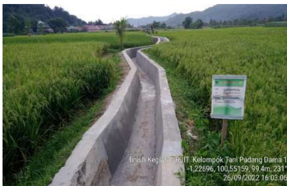
Pembangunan/Rehabilitasi Jaringan Irigasi Tersier di Nagari Koto Baru Koto Barapak Kecamatan Bayang
