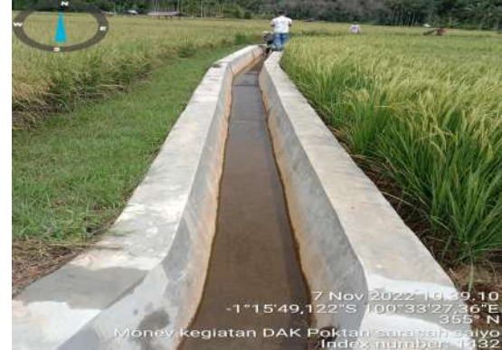
Pembangunan/Rehabilitasi Jaringan Irigasi Tersier di Nagari Sungai Sariak Lumpo Kec. IV. Jurai
